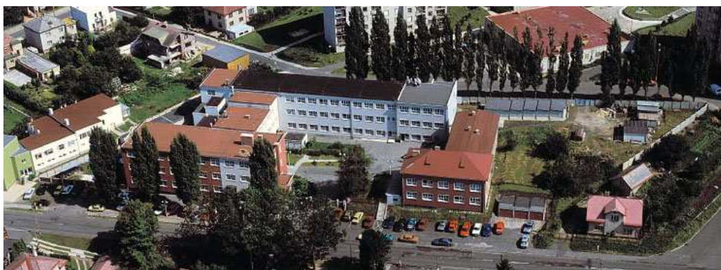
Obr. 1: Budova firmy Granát Turnov (zdroj: www.granat.eu )
