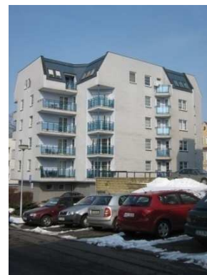
Obr. 8 Vícepodlažní bytový dům
