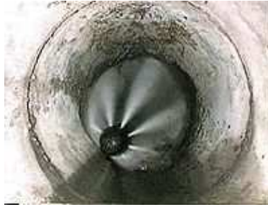
Obr. 1 Čištění potrubí vysokotlakou tryskou
