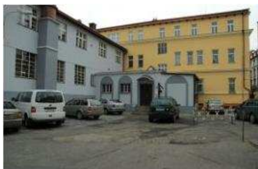
Obrázek č. 14 – Budova společnosti Ecom
