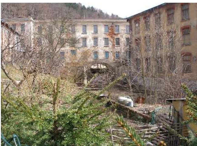
technická památka – třípatrová továrna nad mostním obloukem
