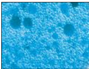
Obr č. 9 PUR pěna – detail
