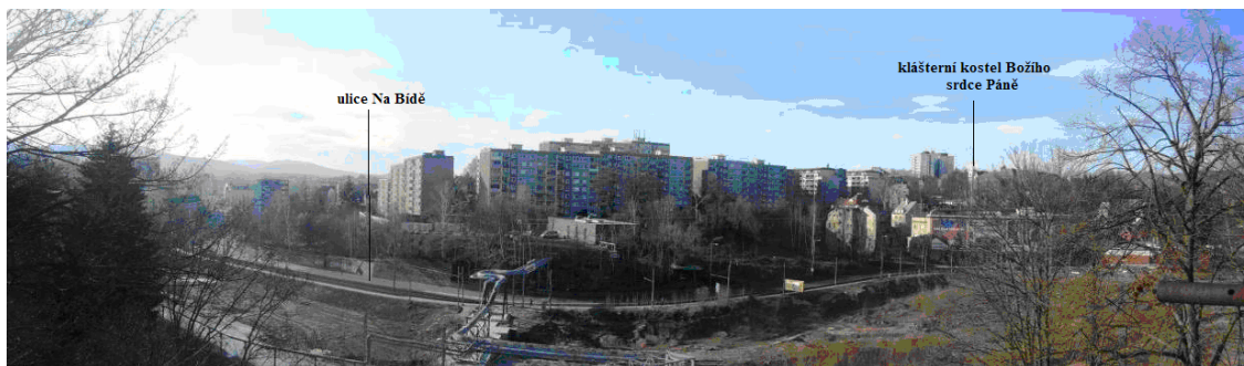
Obr. 9 Panorama severozápadního směru. Zdroj: autor.
