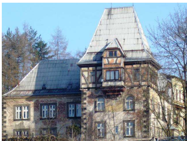
Obr. 8 Budova č.p. 120/V. Zdroj: autor.
