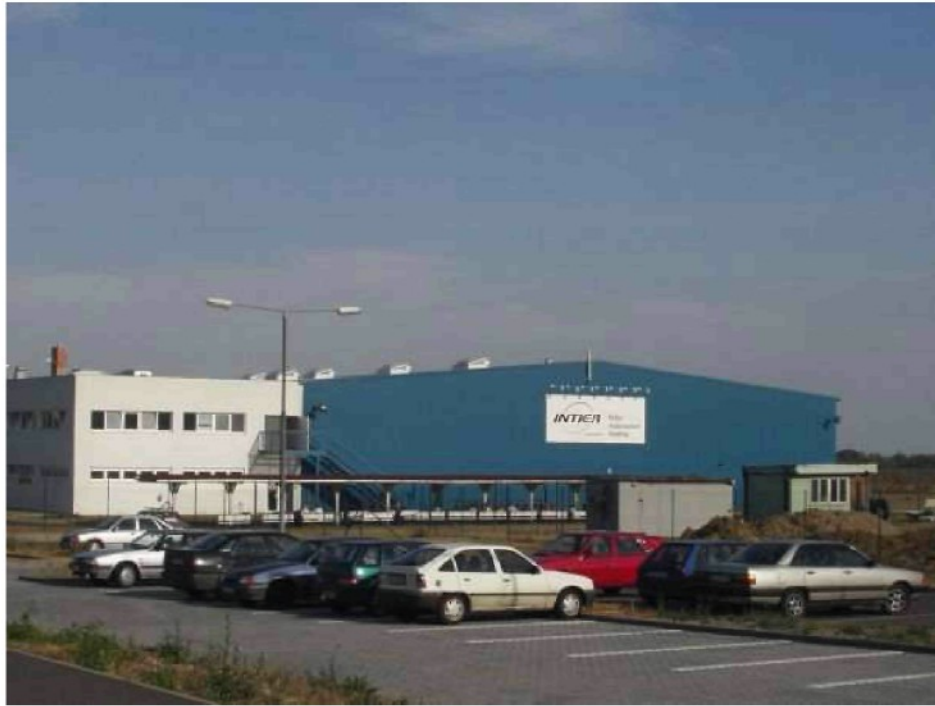
Obr. č. 1: Intier Automotive Seating Chomutov s.r.o.
