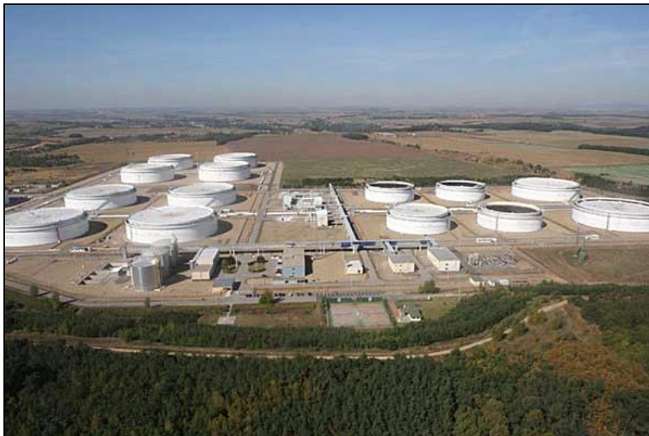
Obr. 6-23 Centrální tankoviště ropy nedaleko Nelahozevsí [20]
