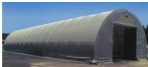
Obr. 1 Textilní hala s ocelovou konstrukcí – oblouková
