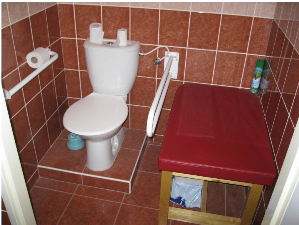
Obrázek č. 4: Bezbariérově upravené toalety na škole s přebalovacím pultem.
