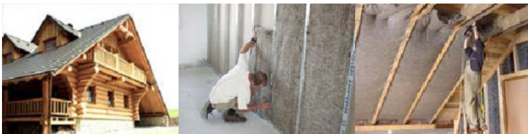
Obrázek 1 : Dřevostavba, aplikace izolačního materiálu Thermowool
