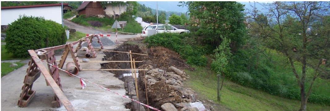
Obr. 94: Budování kanalizace na Letní straně (Kučerová, T. 2010)
