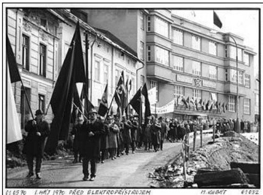
Obr. 13: Rozšiřování silnice v roce 1970. Budova Elektroprístroje ještě není rozšířena (Kubát, M.)
