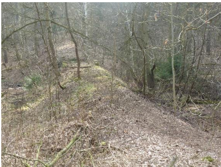
Fotografie 5: Hráz – Oráčovské údolí
