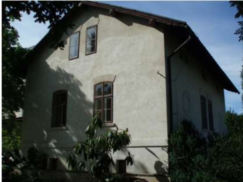
Obrázek 61: Detail dvoupatrové hospodářské budovy umístěné vpravo od hlavního vchodu zámku
