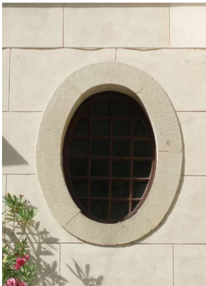
Obrázek 58: Detail oválného okna
