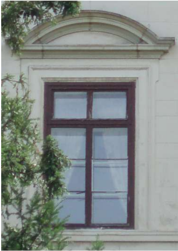
Obrázek 42: Pohled na jednoduché francouzské okno s ostěním. Nad oknem nadokenní římsa s vlysem, jehož výplň odkazuje k renesančnímu tvarosloví. Korunní římsa se nad oknem dělí a zalomením vytváří trojúhelníkový štít, po jehož stranách jsou umístěny kamenné jehlance pylonů ukončených koulemi
