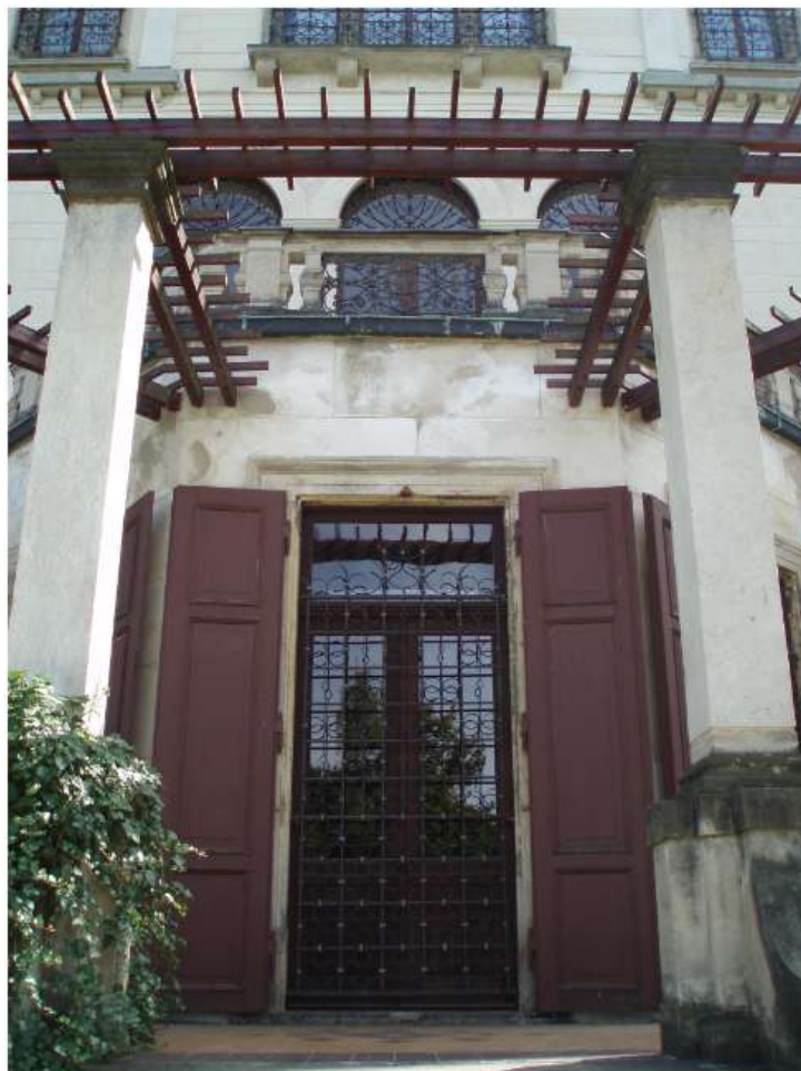
Obrázek 37: Detailní pohled na dveře s dřevěnými křídly a ostěním vedoucí z Velkého sálu do francouzského parku
