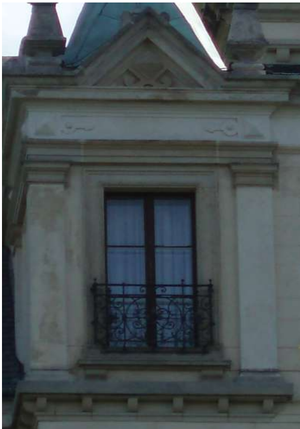
Obrázek 43: Pohled na jednoduché dřevěné okno posazené na podokenní římse lemované šambránou a lištou, nad ním segmentový fronton
