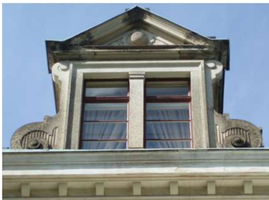
Obrázek 49: Detail sduženého okna s plochým ostěním, jejichž tabule jsou ve středu odděleny pilastrem. Po stranách okna volutová zakončení, nad oknem trojúhelníkový štít s dekorem ploché pásky a koule.
