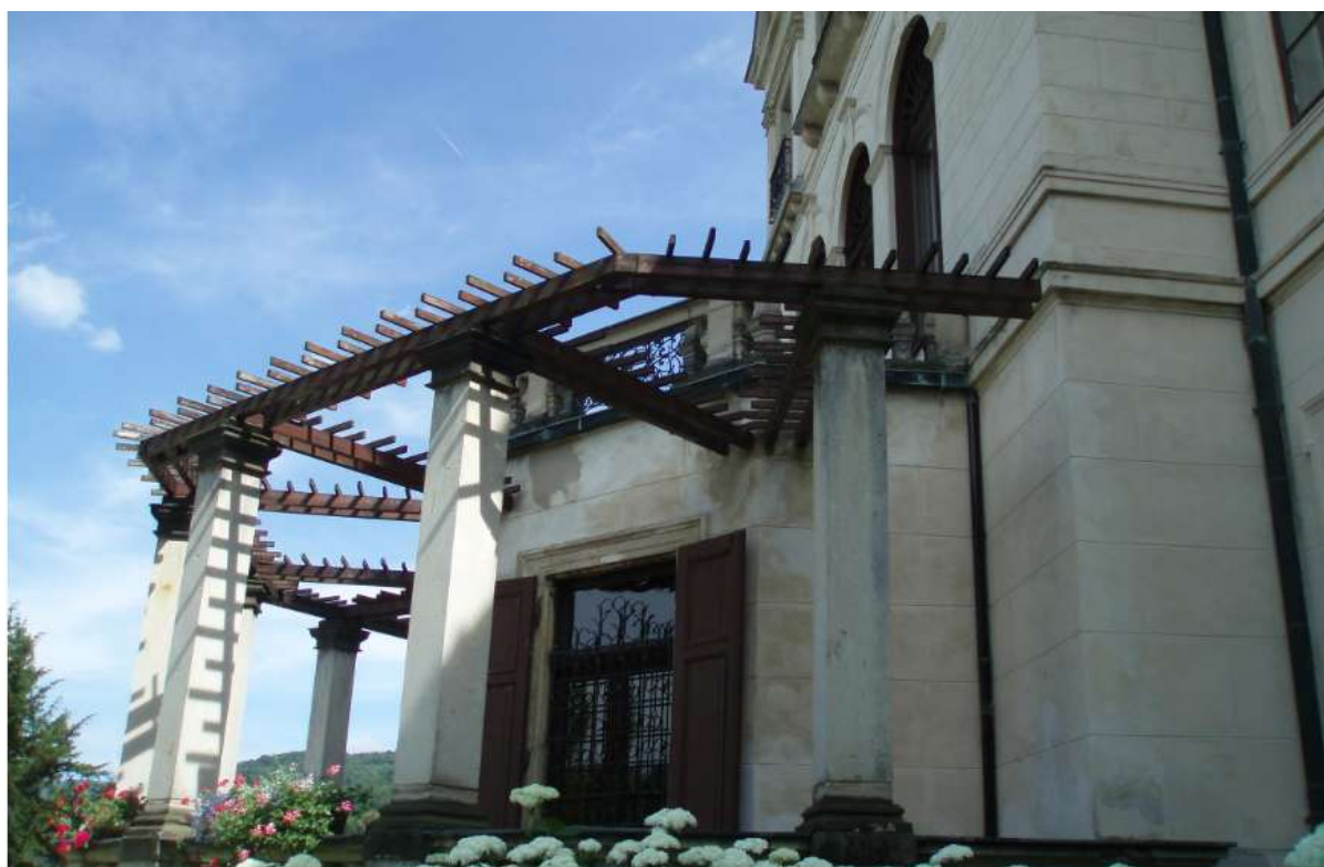
Obrázek 36: Boční pohled na vstupní část severního průčelí s dřevěnou pergolou a balkonem
