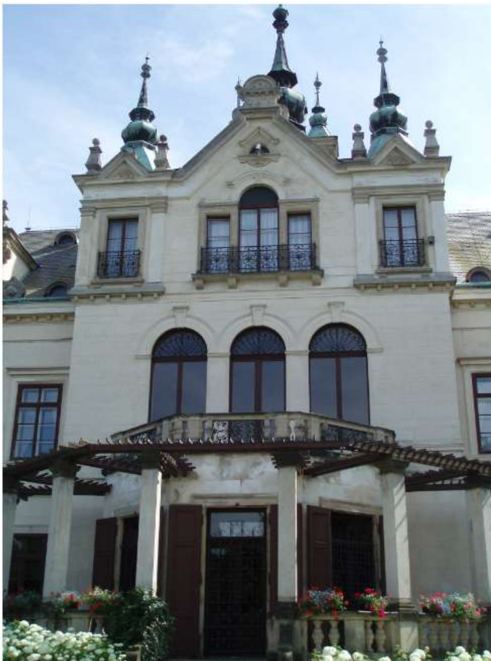
Obrázek 34: Detail na hlavní část budovy ze severní strany
