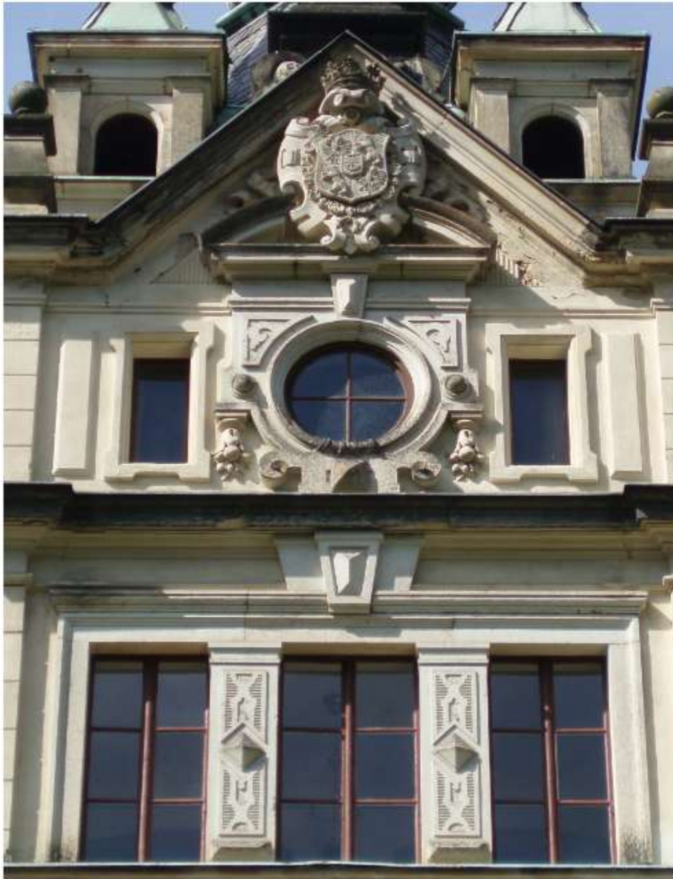
Obrázek 46: Detail na okna s ostěním v druhém nadzemním patře, oddělené pilíři s dekorem ploché pásky s diamantováním. Nad okny lze pozorovat nejvyšší část štítu s lucernami věže
