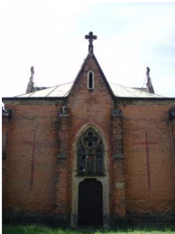
Obrázek 4: Exteriér hrobky ve Valtířově
