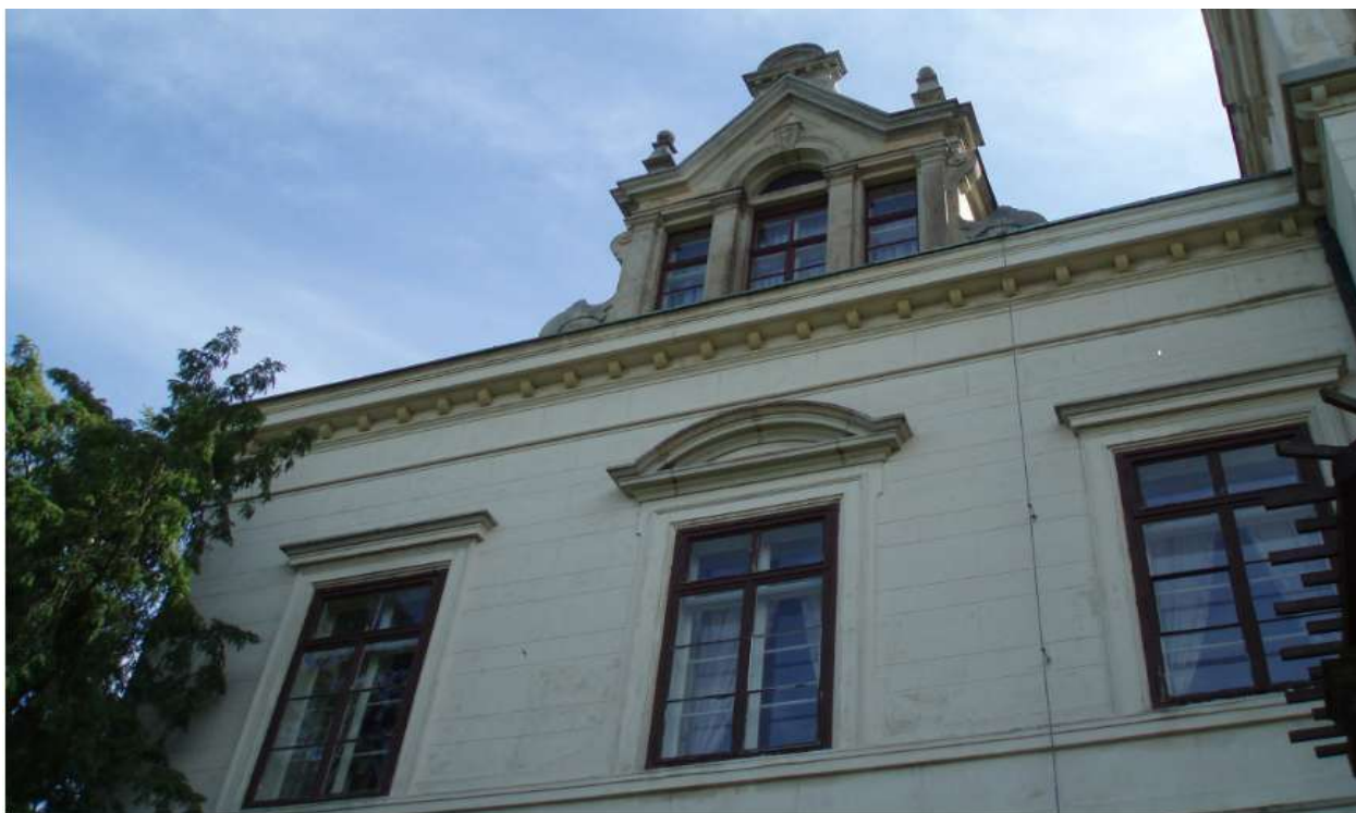
Obrázek 39: Pohled na levou část budovy ze severní strany
