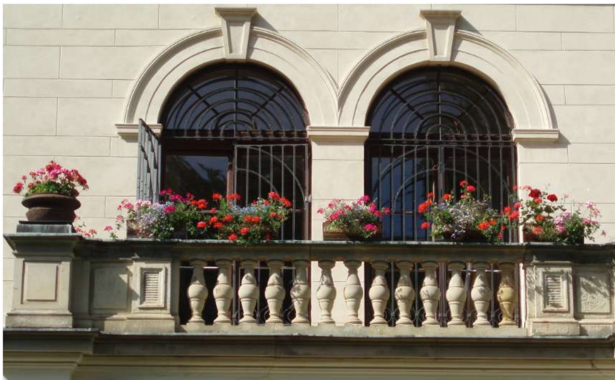
Obrázek 56: Detail dveří, balkonu a balustrády ve druhém nadzemním podlaží
