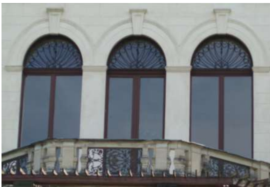
Obrázek 41: Detail dveří a oken ve druhém nadzemní poschodí vedoucí na balkon
