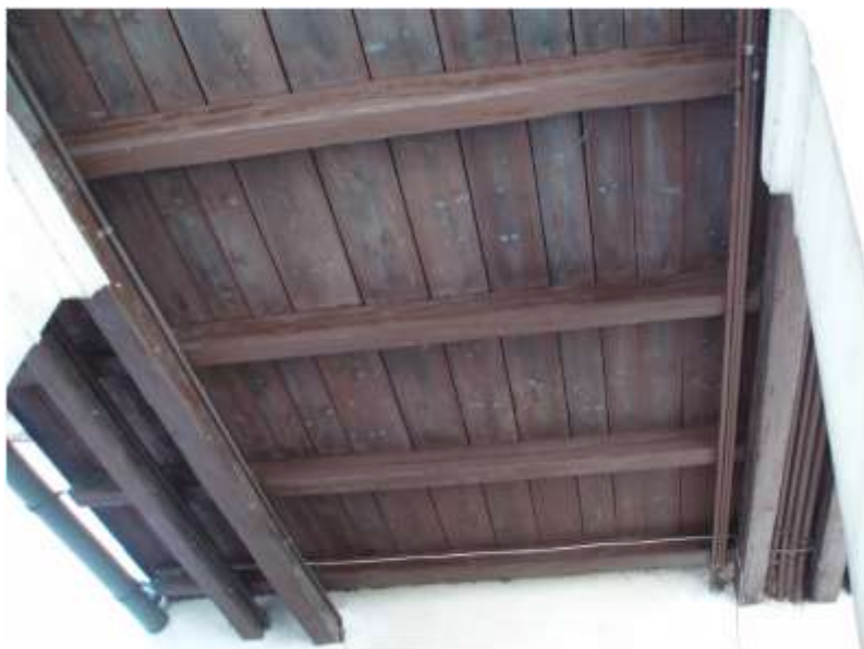
Obrázek 64: Detail dřevěné promenády ze spodní strany
