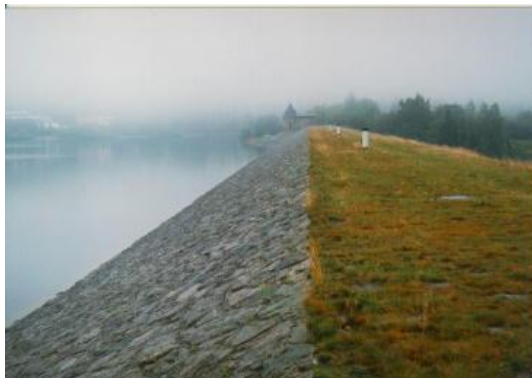
Obr. č. 7: Vodní nádrž Souš
