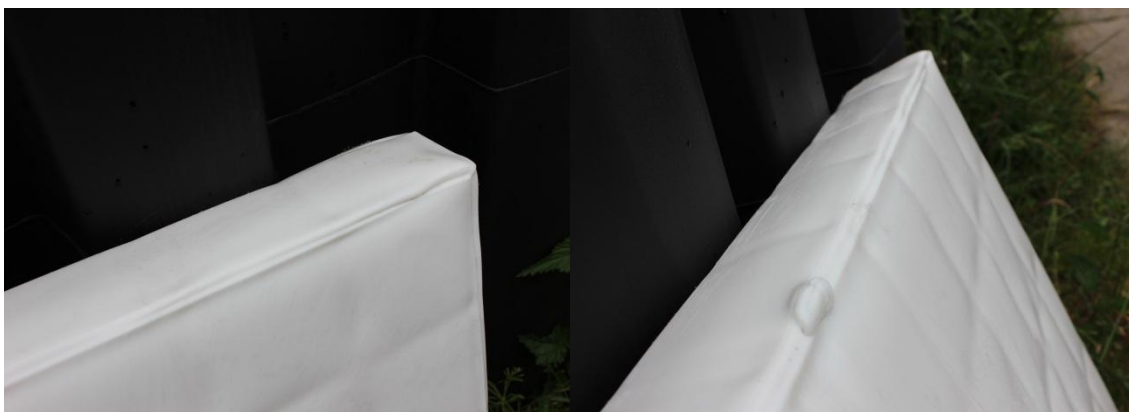
Obr. 22 Propadliny a deformace na stěnovém prvku
