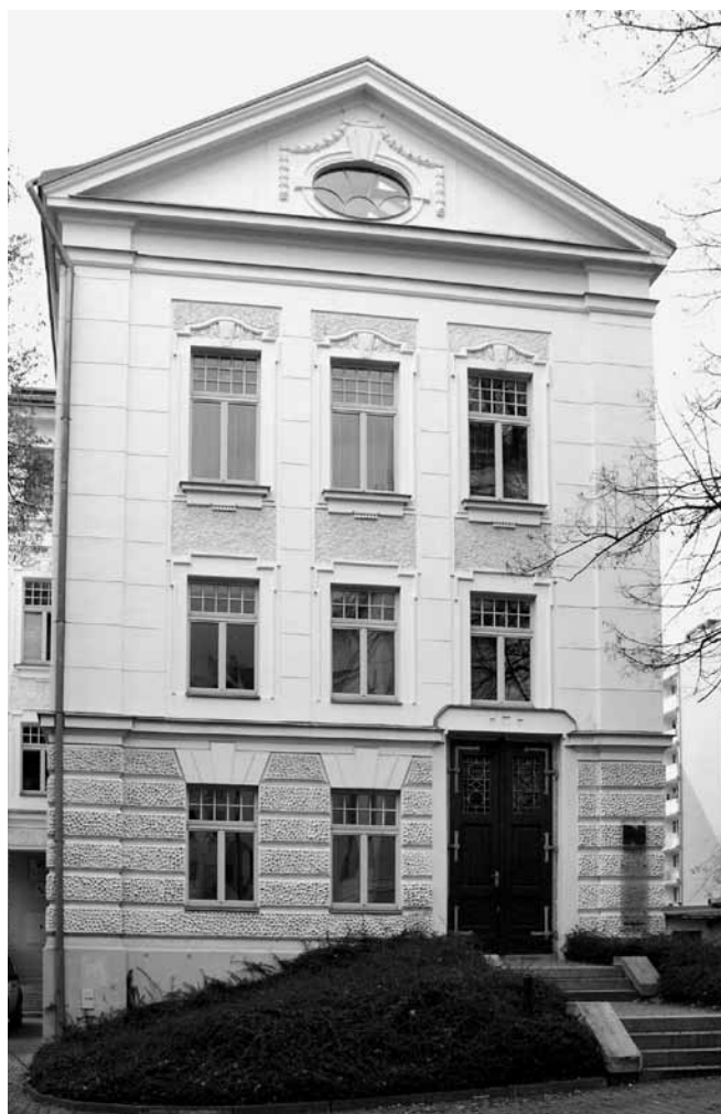
Budova Galerie N, foto Zdena Hájková, 2013
