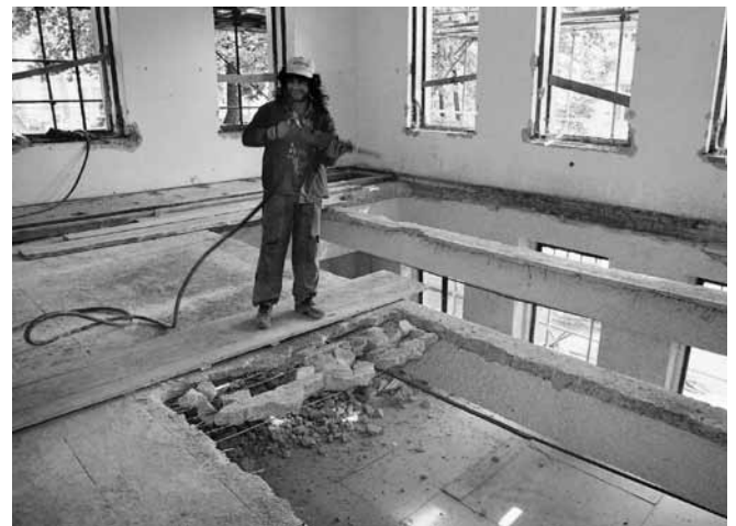
Rekonstrukce ochozu galerie, archiv Petr Krajíček, 2002
